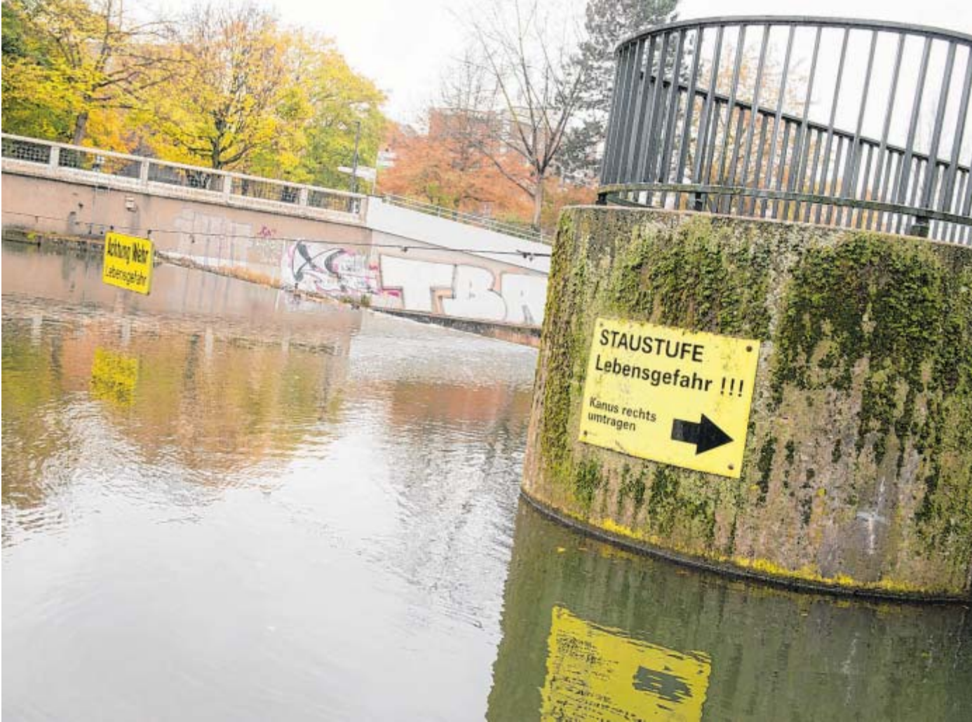
Wehr mit Warnschildern: Wer über die Kante der Wehrwand kippt – schwimmend oder mit dem Boot – hat ein Problem. Aber schon vor der Wehrwand würde der Sog des Wassers Schwimmer nach unten ziehen.
