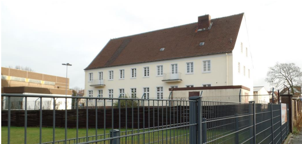
Abbildung 2: Blick auf das Bürogebäude, im Hintergrund das NAAFI-Kaufhaus
