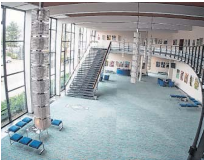
Theater: Neue Anforderungen für Fluchtwege, vor allem aus dem Obergeschoss, machen ein überarbeitetes Brandschutzkonzept vor der anstehenden Gesamt- sanierung notwendig. FOTO: RALF BITTNER
