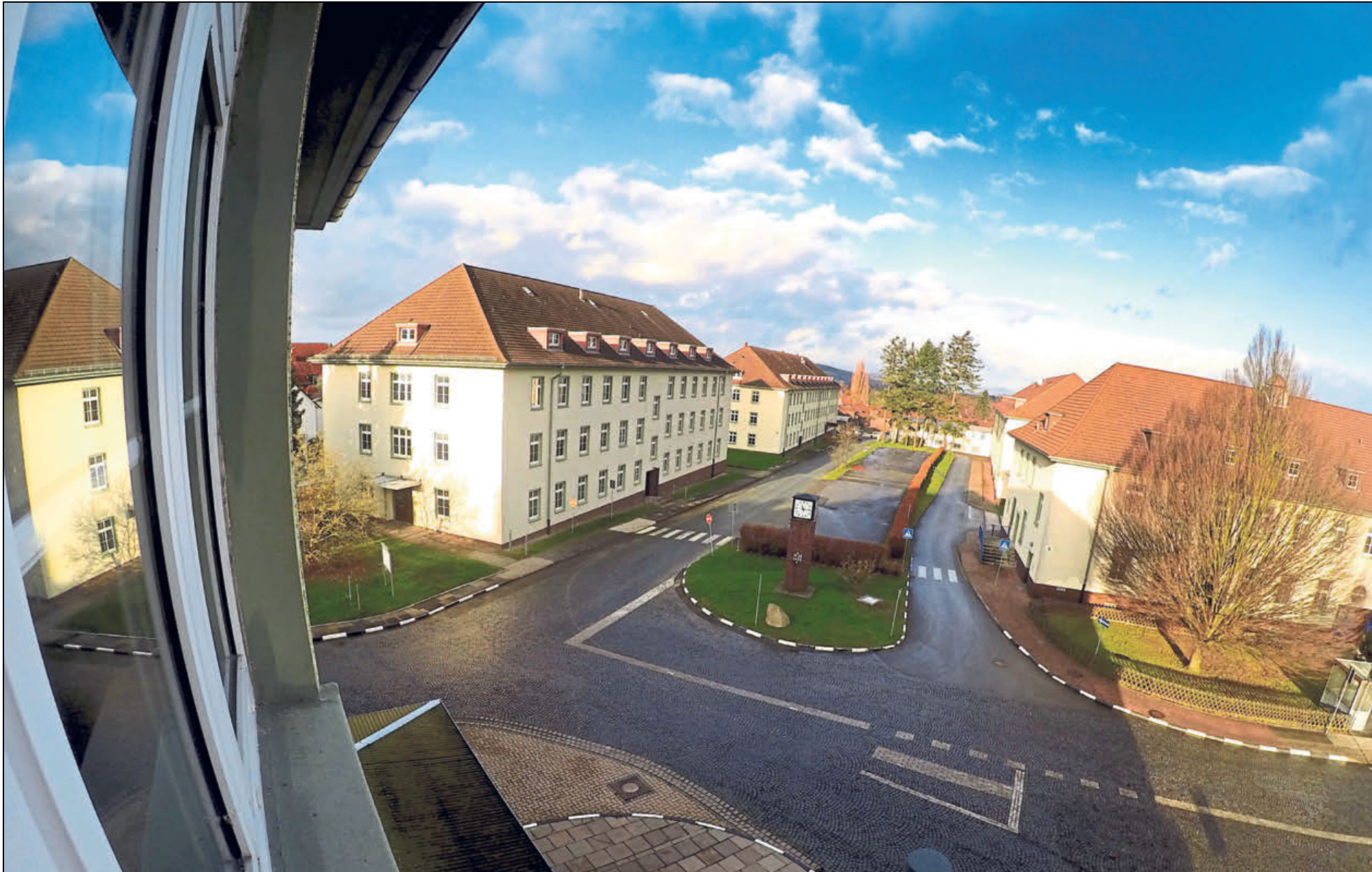
Sechs Gebäude will die Stadt auf dem Areal der Hammersmith-Kaserne kaufen und für die Fachhochschule für Finanzen nutzen, wenn der Rat den Plänen zustimmt. Für Erwerb, Sanierung und Umbau dieser Immobilien und eines weiteren Gebäudes der Wentworth-Kaserne werden 36,3 Millionen Euro veranschlagt, Foto: Moritz Winde
