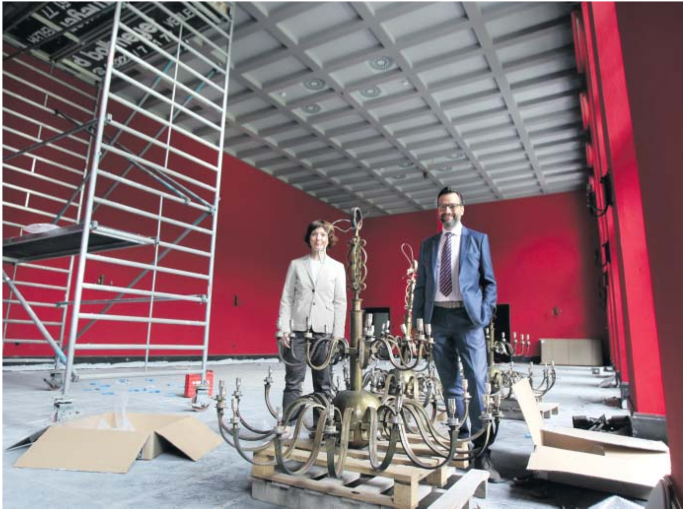
Vornehm: Manuela Breiter und Norbert Landshut von der Stadtentwicklungsgesellschaft in der künftigen Mensa, die früher ein Ballsaal des Offizierskasinos gewesen ist. Noch warten die Kronleuchter auf ihre Befestigung an der Decke.
