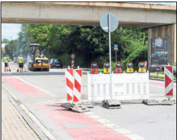
Die Bielefelder Straße ist wegen der Baustelle zurzeit nur stadteinwärts befahrbar.
