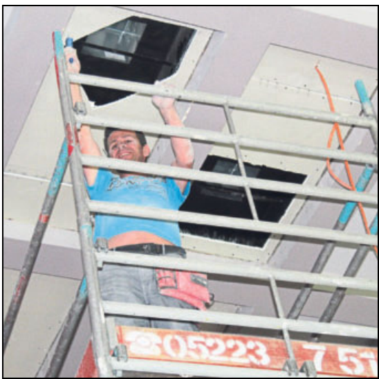
Die alte Kassettendecke wird aufgeschnitten für den Einbau einer Belüftungsanlage.
