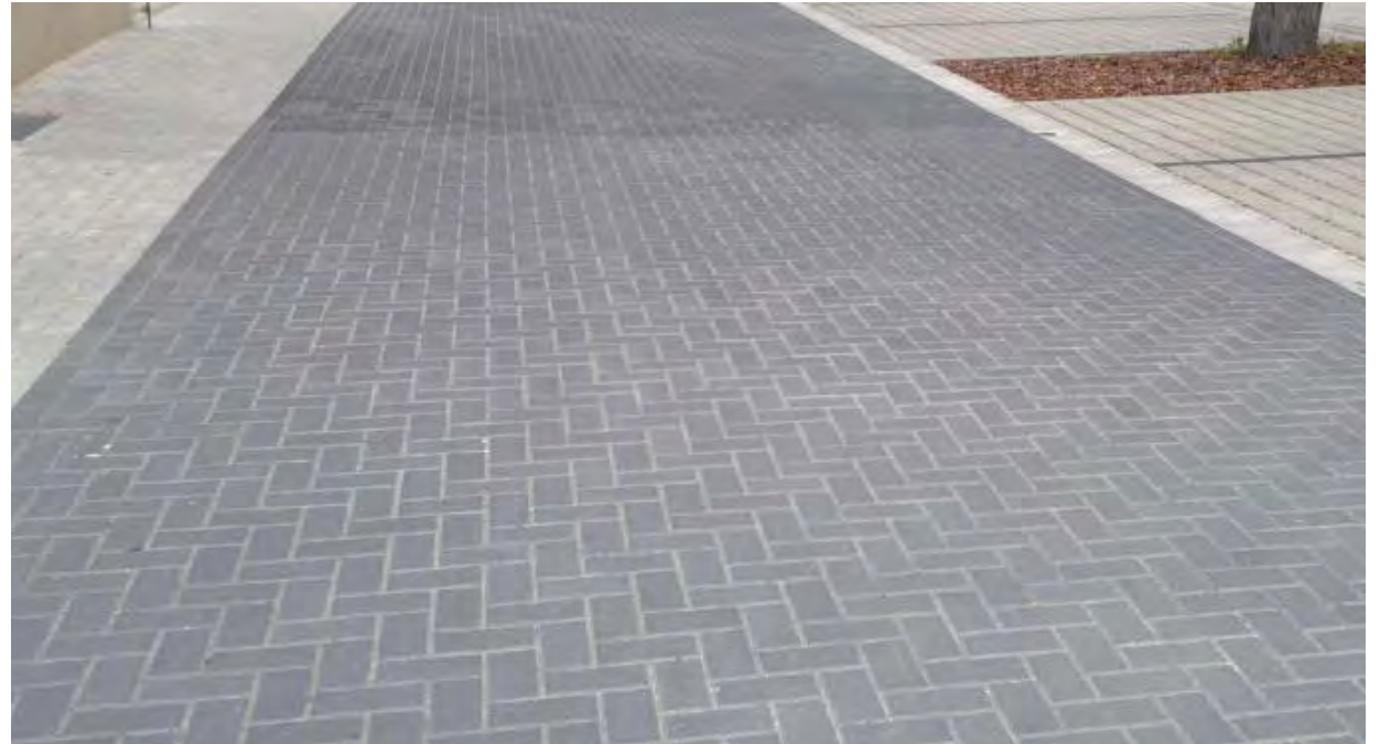
Betonsteinpflaster in Anliegerstraße ab Augustastraße
