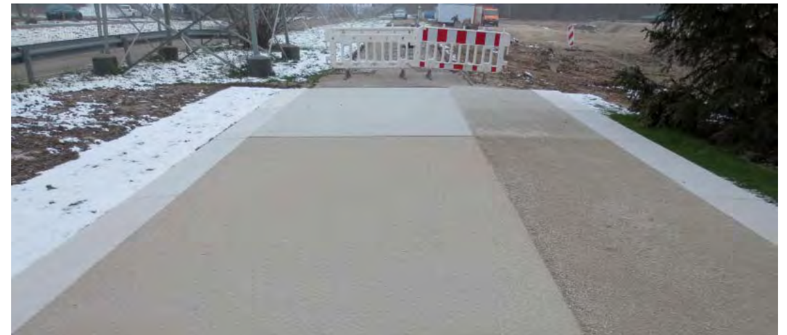
Musterfläche Asphalt - Wassergebundene Decke
