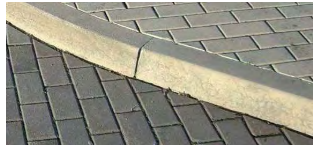
Betonsteinpflaster in Anliegerstraße ab Augustastraße
