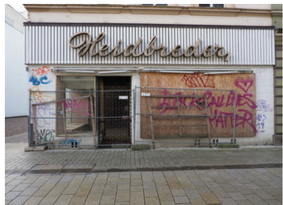
Abbildung 28: Leerstand in der Herforder Innenstadt mit starken baulichen Defiziten
