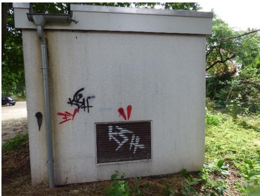
Abb. 29 Nordansicht von Gebäude 4.
