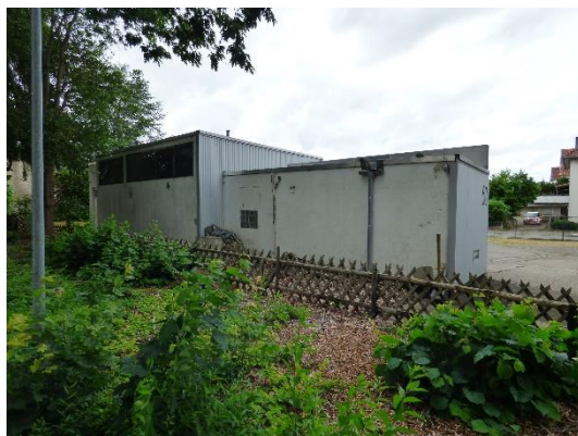
Abb. 41 Südansicht von Gebäude 7.
