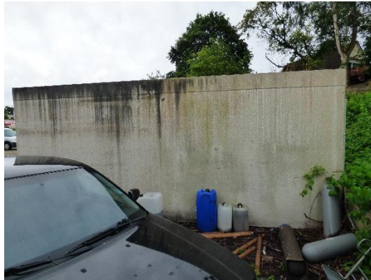
Abb. 21 Nordansicht von Gebäude 2.
