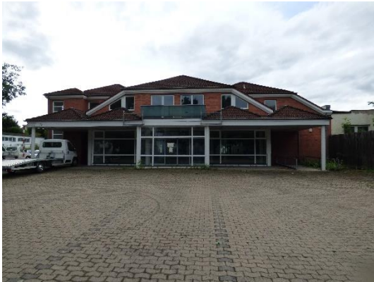
Abb. 6 Leerstehendes Gebäude eines Lebensmittelmarktes.
