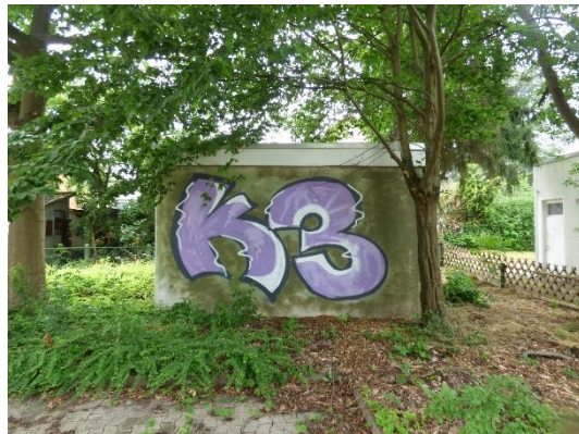
Abb. 28 Ostansicht von Gebäude 4.
