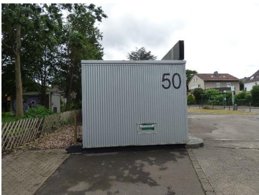
Abb. 40 Ostansicht von Gebäude 7.
