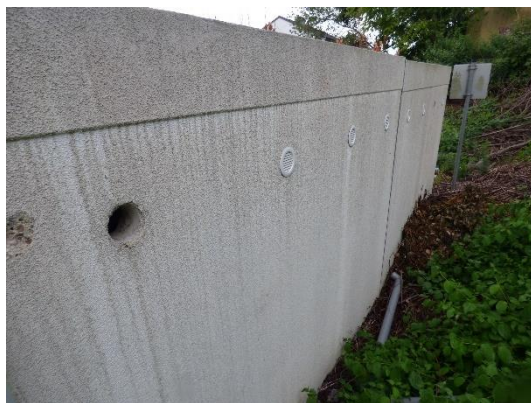
Abb. 23 Westansicht von Gebäude 2.
