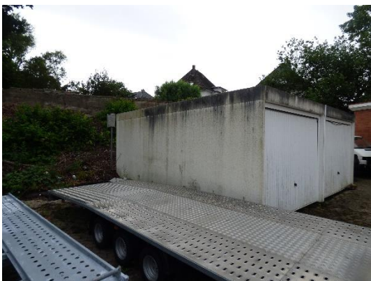
Abb. 22 Südansicht von Gebäude 2.
