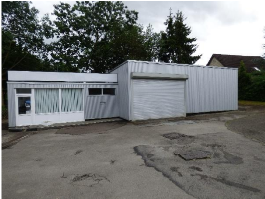
Abb. 38 Nordansicht von Gebäude 7.
