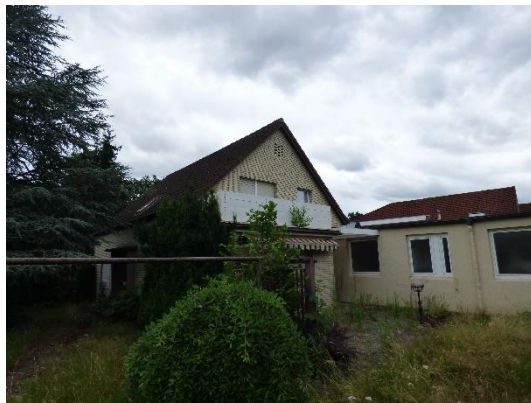
Abb. 34 Westansicht von Gebäude 5.
