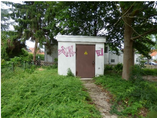
Abb. 27 Südansicht von Gebäude 4.
