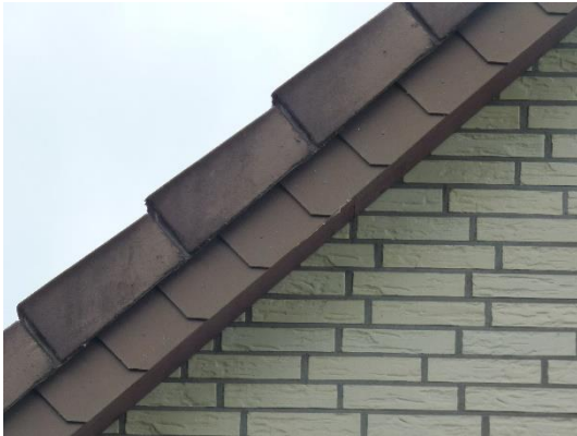
Abb. 35 Ortgänge an Gebäude 5.
