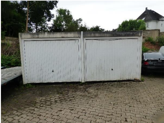
Abb. 20 Ostansicht von Gebäude 2.
