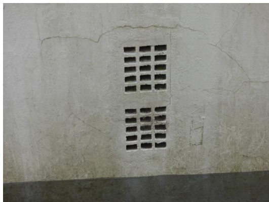
Abb. 43 Lüftungsspalten an der Südseite von Gebäude 7.
