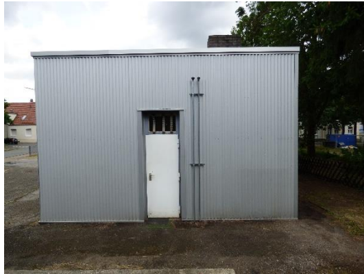
Abb. 39 Westansicht von Gebäude 7.
