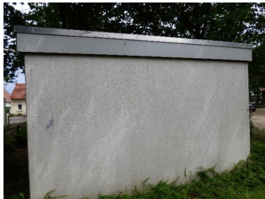
Abb. 30 Westansicht von Gebäude 4.
