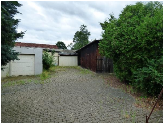
Abb. 36 Nordansicht von Gebäude 6.
