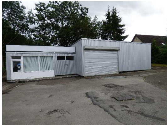
Abb. 9 Gebäude eines Gewerbebetriebes im Plangebiet.
