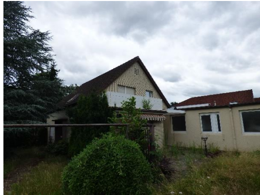
Abb. 7 Leerstehendes Wohngebäude im Plangebiet.
