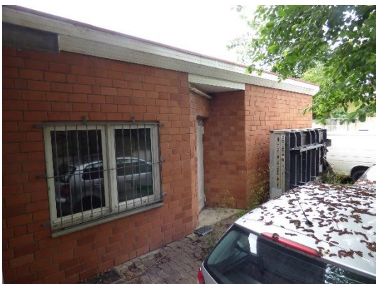
Abb. 18 Westansicht von Gebäude 1.
