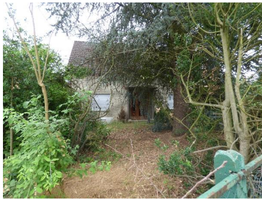
Abb. 32 Nordansicht von Gebäude 5.
