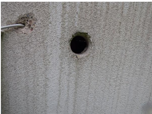
Abb. 24 „Lüftungsloch“ an Gebäude 2.
