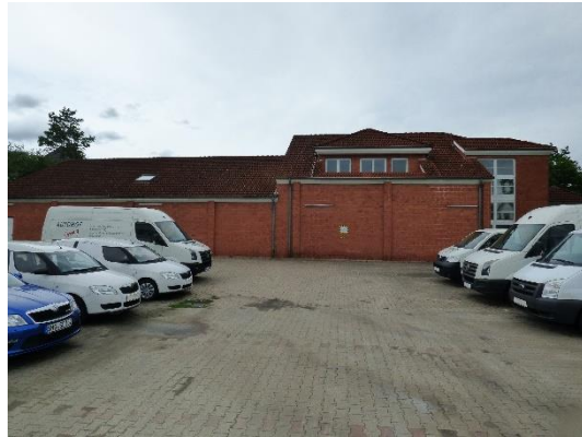
Abb. 17 Südansicht von Gebäude 1.
