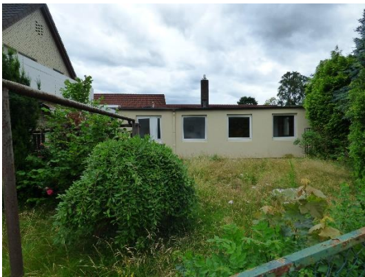
Abb. 33 Nordansicht von Gebäude 5.
