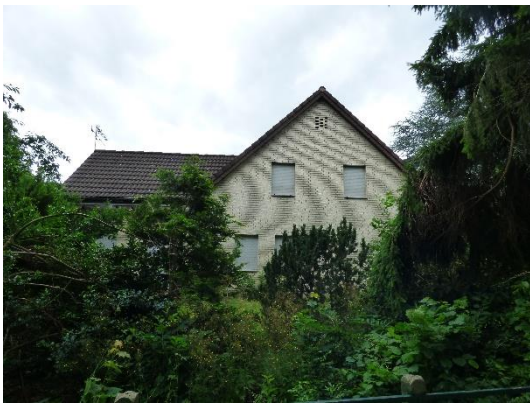
Abb. 31 Ostansicht von Gebäude 5.
