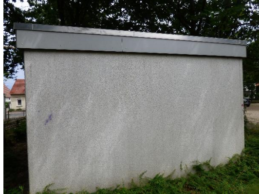
Abb. 27 Westansicht von Gebäude 4.
