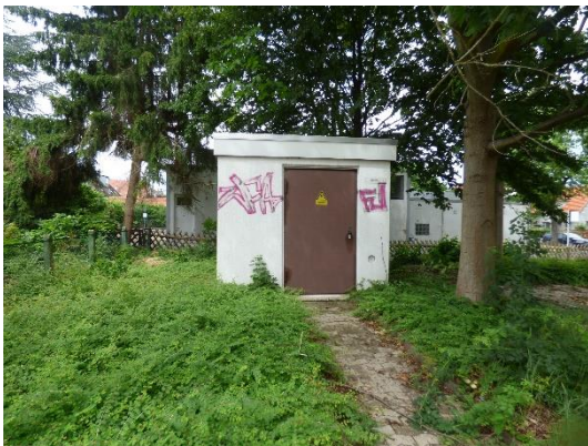
Abb. 24 Südansicht von Gebäude 4.
