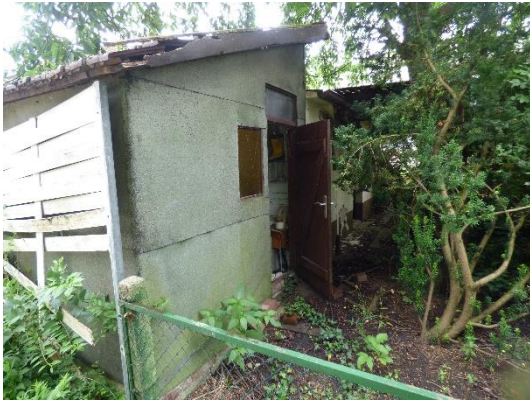
Abb. 22 Offene Türen an Gebäude 3.
