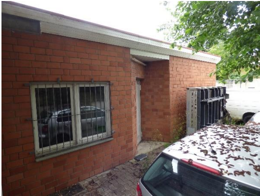
Abb. 15 Westansicht von Gebäude 1.
