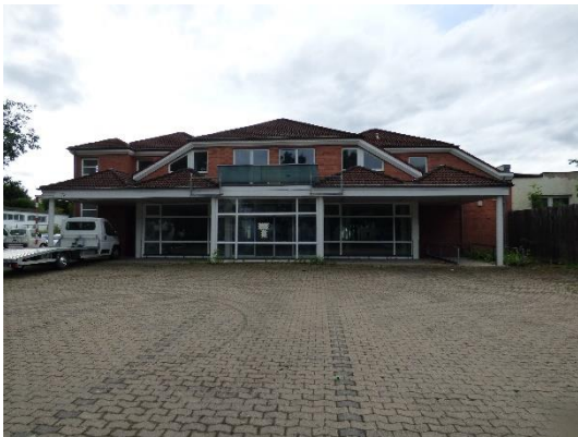
Abb. 13 Ostansicht von Gebäude 1.
