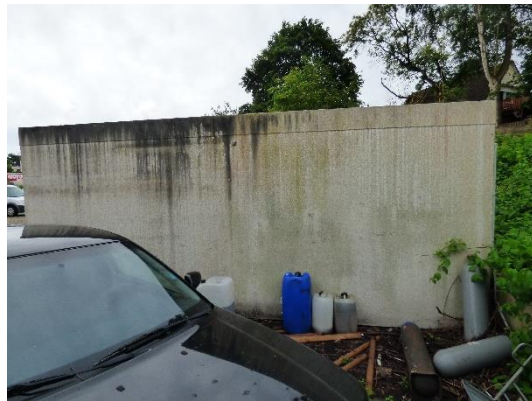
Abb. 18 Nordansicht von Gebäude 2.
