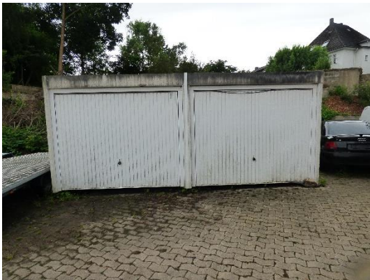
Abb. 17 Ostansicht von Gebäude 2.
