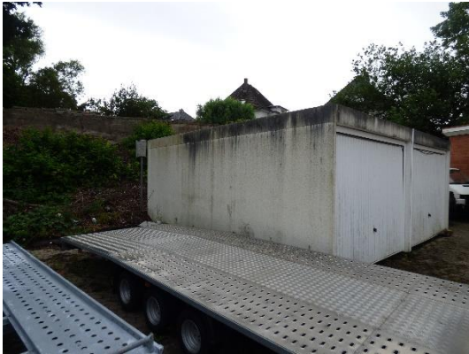
Abb. 19 Südansicht von Gebäude 2.
