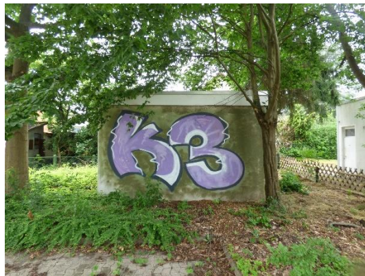
Abb. 25 Ostansicht von Gebäude 4.
