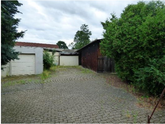
Abb. 33 Nordansicht von Gebäude 6.
