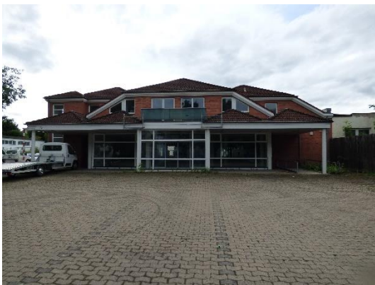
Abb. 4 Leerstehendes Gebäude eines Lebensmittelmarktes.
