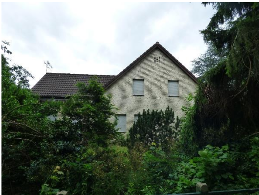
Abb. 28 Ostansicht von Gebäude 5.
