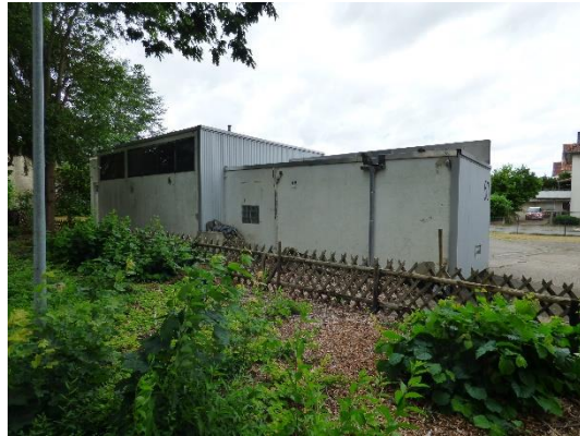
Abb. 38 Südansicht von Gebäude 7.
