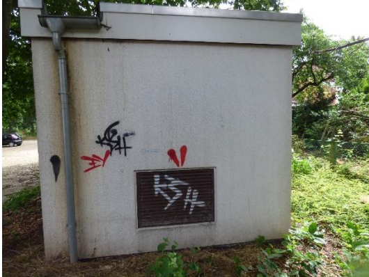
Abb. 26 Nordansicht von Gebäude 4.
