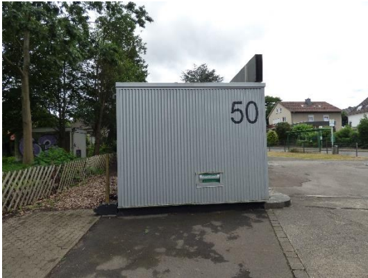
Abb. 37 Ostansicht von Gebäude 7.
