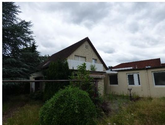
Abb. 5 Leerstehendes Wohngebäude im Plangebiet.
