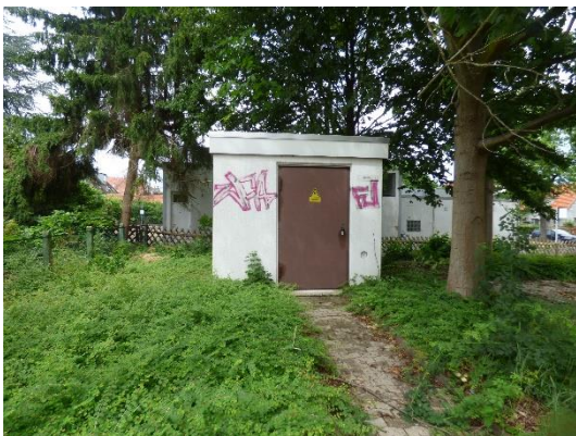
Abb. 6 Trafohaus im Plangebiet.
