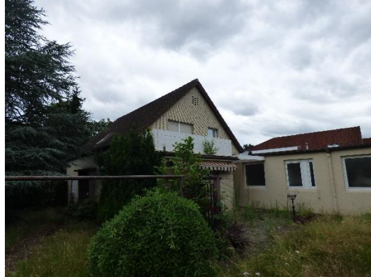
Abb. 31 Westansicht von Gebäude 5.
