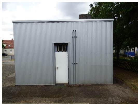
Abb. 36 Westansicht von Gebäude 7.
