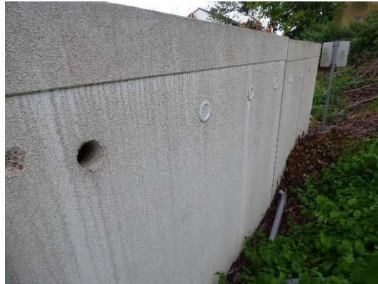
Abb. 20 Westansicht von Gebäude 2.
