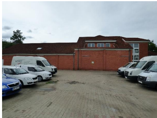
Abb. 14 Südansicht von Gebäude 1.
