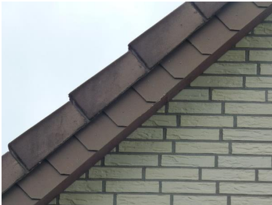
Abb. 32 Ortgänge an Gebäude 5.
