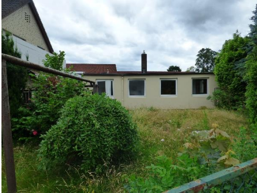
Abb. 30 Nordansicht von Gebäude 5.
