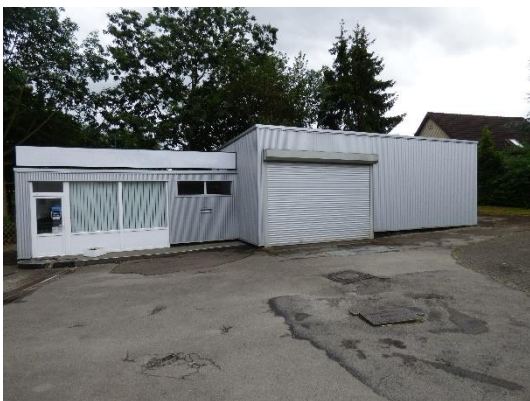
Abb. 35 Nordansicht von Gebäude 7.
