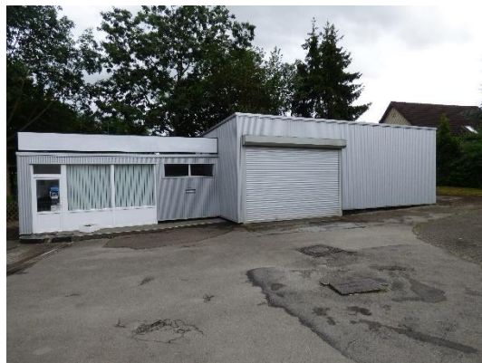
Abb. 7 Gebäude eines Gewerbebetriebes im Plangebiet.
