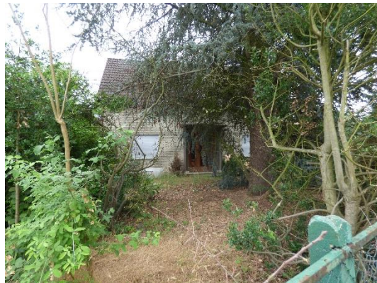
Abb. 29 Nordansicht von Gebäude 5.
