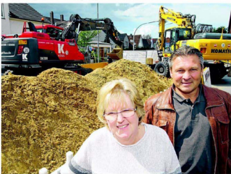
Doppelbetroffen: Conny Grigolat wohnt auf der einen Seite der Salzafer Straße, auf der anderen Seite betreibt die Friseurin die Geschäft. Schäfer ist Michael Schäfer hat sie an der Kanalschachtelle bewacht.
