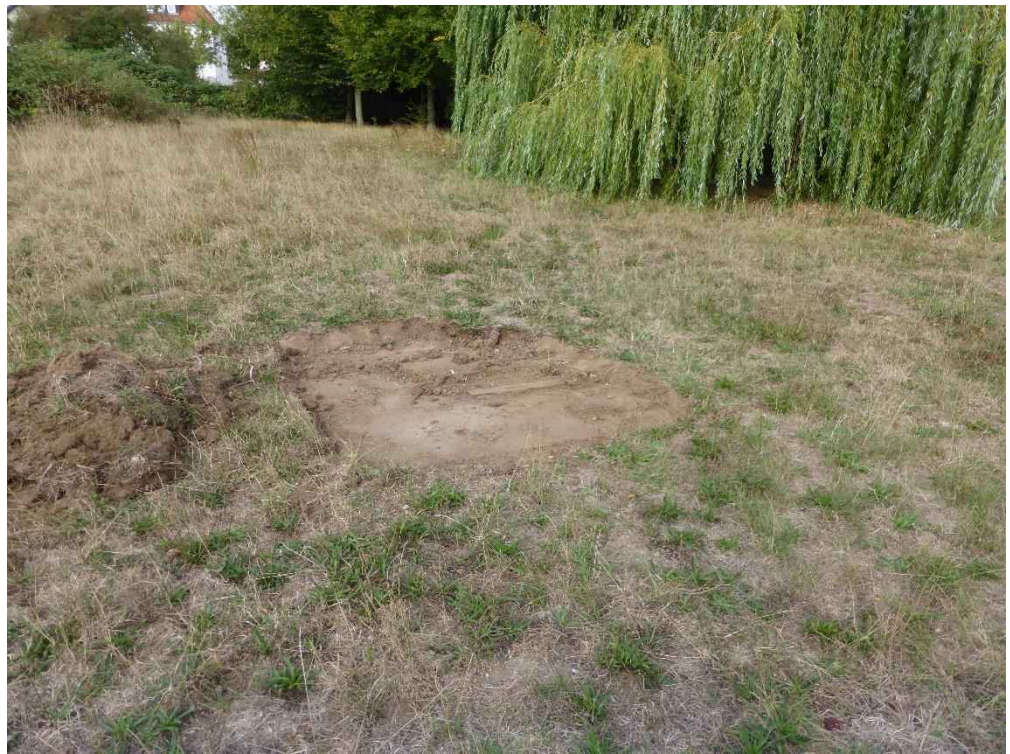
Foto 3: Betonfunda- ment bei RKS 10, vermutlich Kranbahnrest
