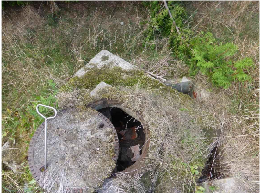
Foto 1: Schacht bei RKS 1, Süd
