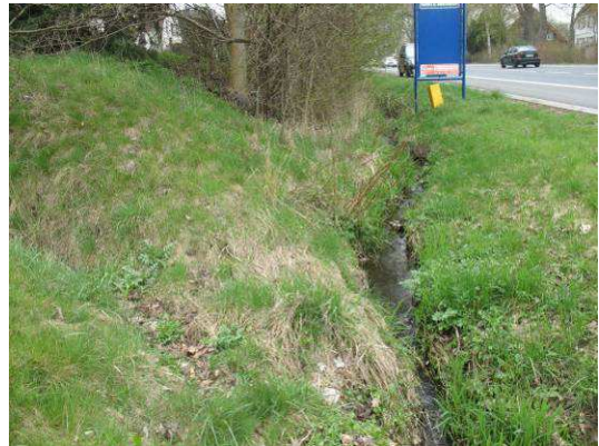
Abb. 28 Mündungs- bereich des namenlosen Baches in den Steinsieksbach.
