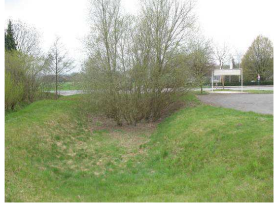
Abb. 17 Südöstlich gelegenes Regenrückhaltebecken.
