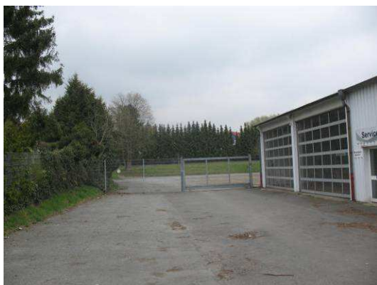
Abb. 7 Westliche Zufahrt und Zaunanlage.
