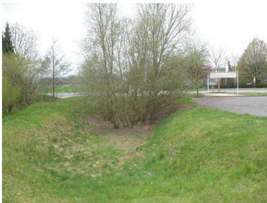
Abb. 32 Regenrückhaltebecken im Südosten des Plangebietes.
