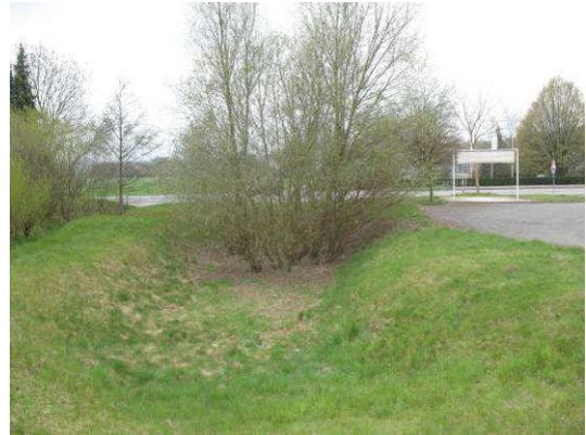
Abb. 17 Südöstlich gelegenes Regenrückhaltebecken.
