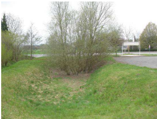
Abb. 32 Regenrückhaltebecken im Südosten des Plangebietes.
