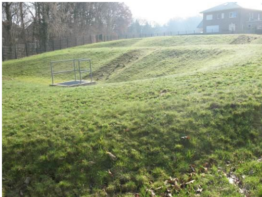
Abb. 16 Versickerungsmulde südlich des Plangebiets.
