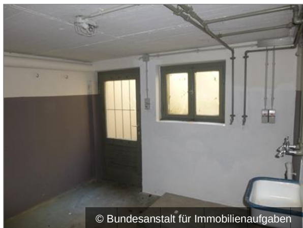
Waschküche im Keller
