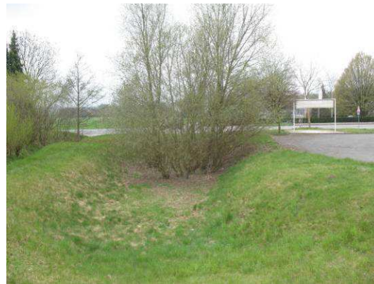
Abb. 17 Südöstlich gelegenes Regenrückhaltebecken.
