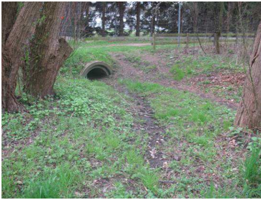
Abb. 23 Verlauf des Namenlosen Baches nördlich des Plangebietes.
