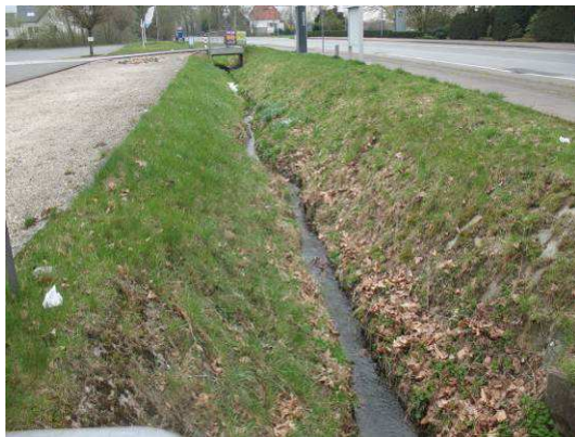
Abb. 16 Steinsieksbach im Plangebiet.
