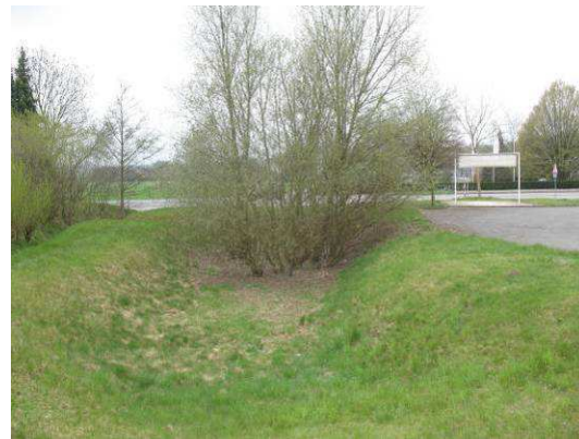
Abb. 17 Südöstlich gelegenes Regenrückhaltebecken.
